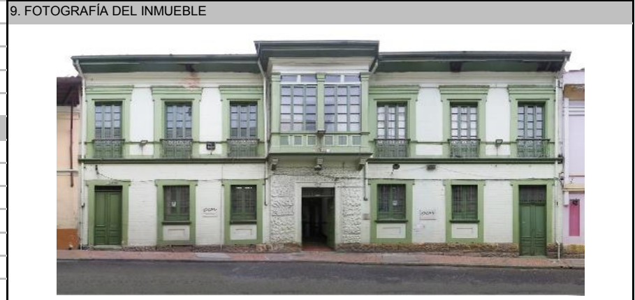
Fuente: Equipo Fotografía PEMP Patrimonio Inmueble
